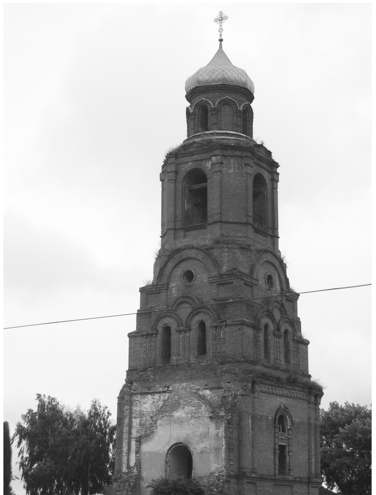
Сохранившаяся колокольня Троицкого храма в Вяземке
